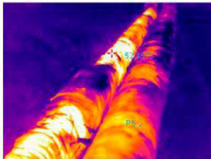
Рис 3. Тепловізійна зйомка повітряної прокладки теплових мереж
