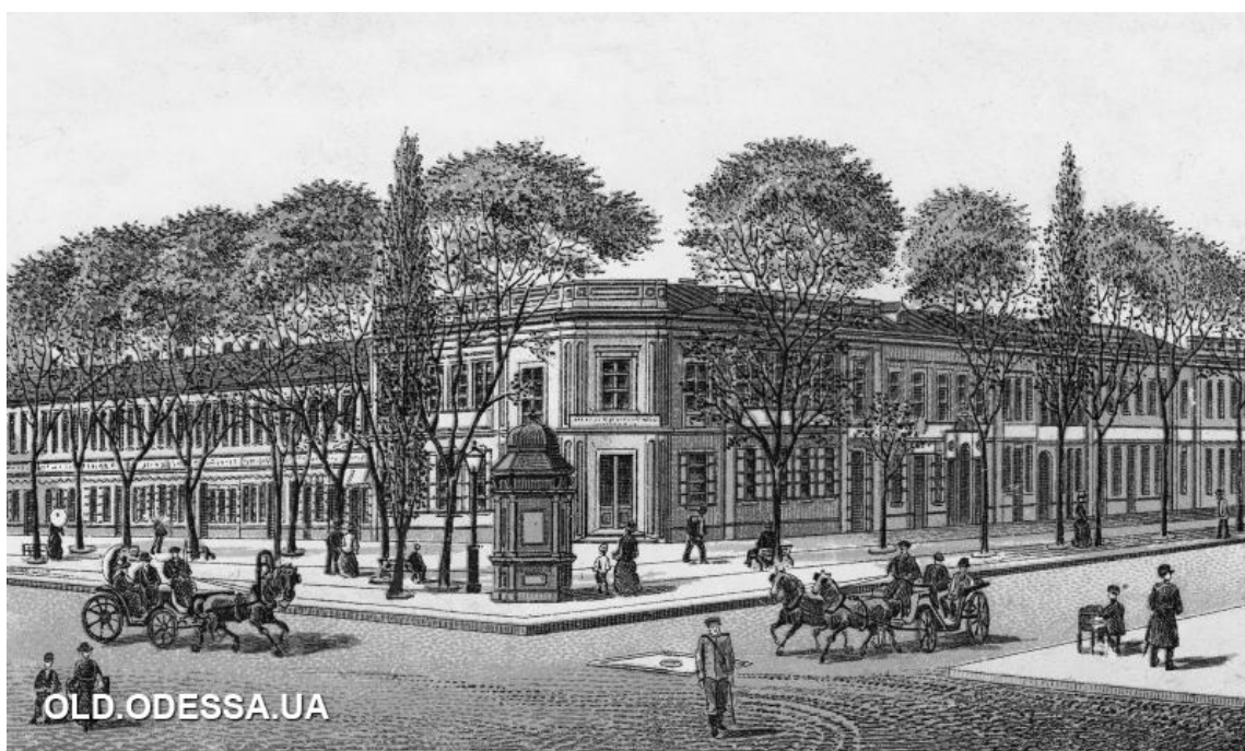
Рис.167. Будівля Рішельєвського ліцею.
