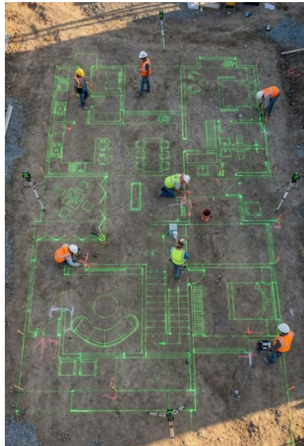
Рис. 1. - Лазерне проектування плану поверху будинку на будівельній ділянці.
